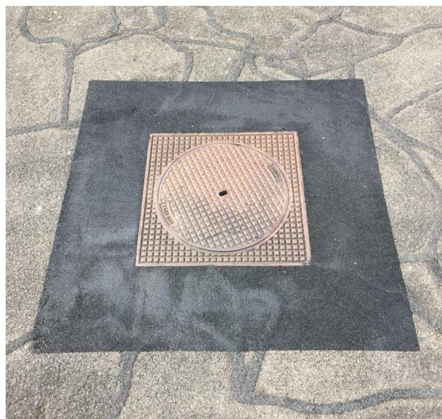
**BB-RM** ist eine 2-komponentige, schnellhärtende, flexibilisierte und gefüllte Beschichtung auf Basis von Polymethylmethacrylat
